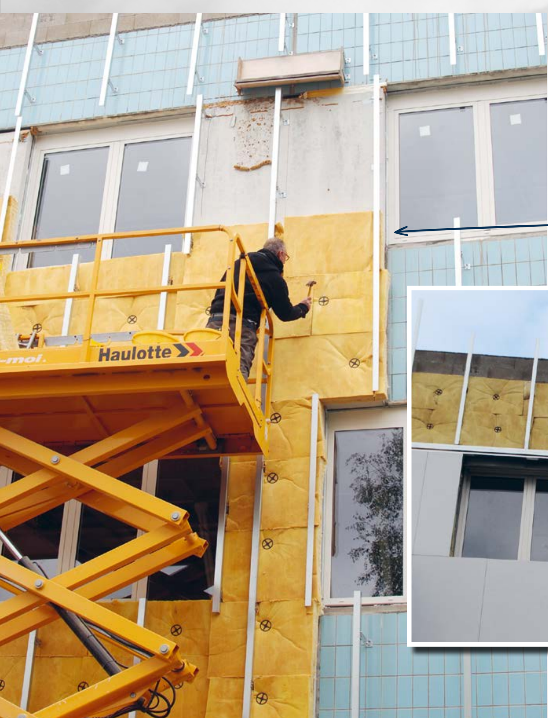
Les nichoirs sont entourés d'isolant, puis recouvert par le bardage
