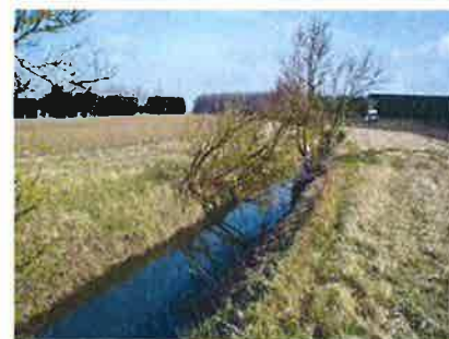
Un fossé de drainage agricole au Nord du site
