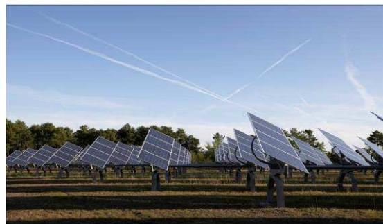
Figure 6 - Installations sur support fixe en rangées (à gauche) et sur support pivotant (à droite – *tracker* ©*exosun*).
