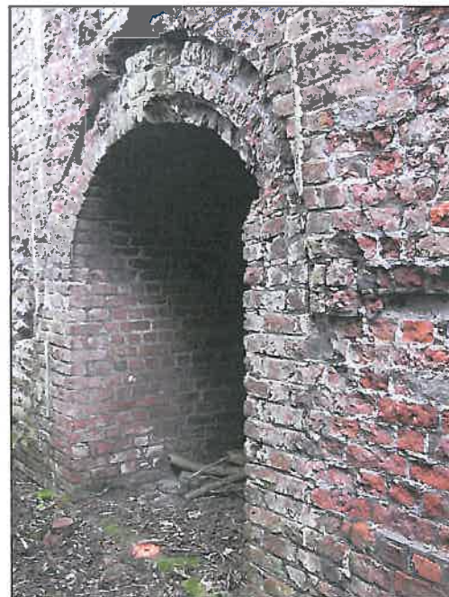
Figure 8 : Photographies de l'entrée de la dynamitière - Présence d'une fissure
