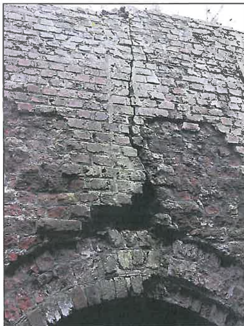
Figure 8 : Photographies de l'entrée de la dynamitière - Présence d'une fissure
