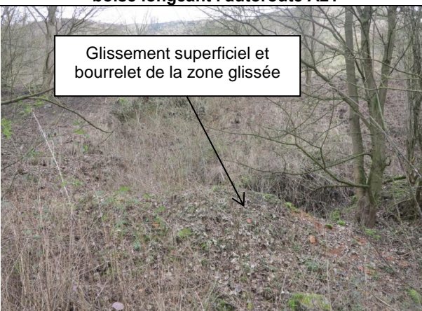
Photographie 4 : Vue d'un flan du terril 83 en partie ouest, signe de glissement superficiel
