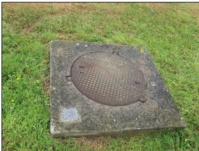
Figure 2 : Localisation du puits 7
