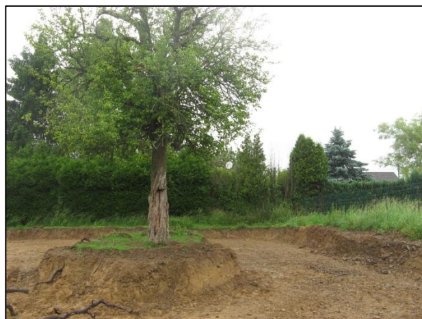
Vue vers le nord-est
