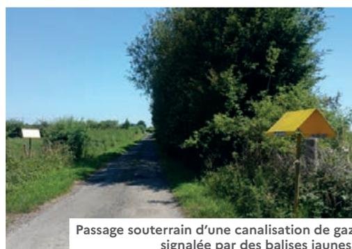
Passage souterrain d'une canalisation de gaz signalée par des balises jaunes.
