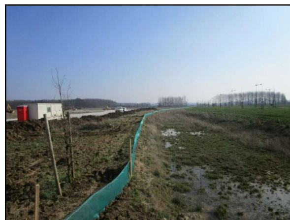
Photo 11B : Exemple d'isolement de chantier (Rainette)
