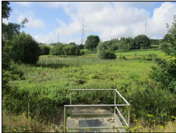
Photo 9B : Bassin Sanef (Rainette, 2017)
