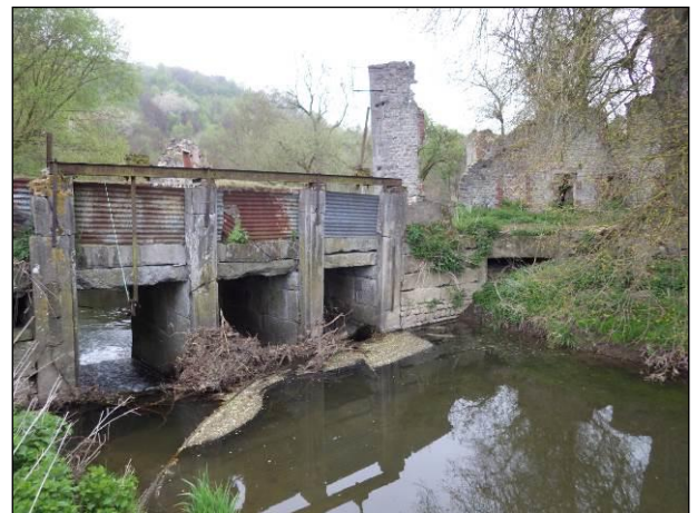
➤ Figure 44 : Vue de l'ouvrage encombré - le 15-04-17
