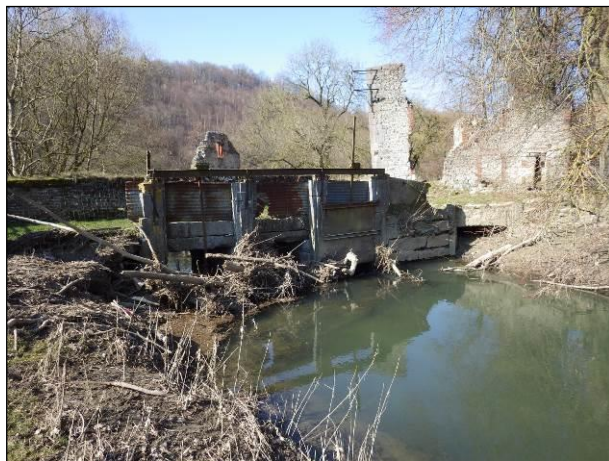
➤ Figure 43 : Vue de l'ouvrage encombré - le 17-03-17
