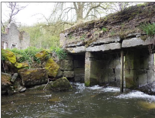
➤ Figure 27 : Vue de l'ouvrage en avril 2017
