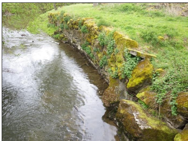
➤ Figure 72 : Vue du mur en enrochements
