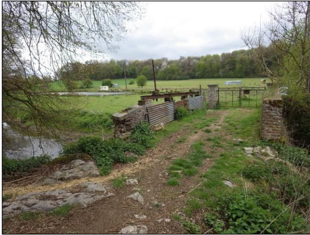
➤ Figure 25 : Vue de l'ouvrage en avril 2017
