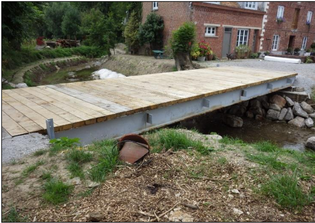
➤ Figure 68 : Vue d'une passerelle mixte bois/métal
