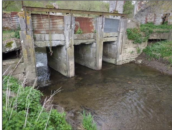
➤ Figure 26 : Vue de l'ouvrage en avril 2017
