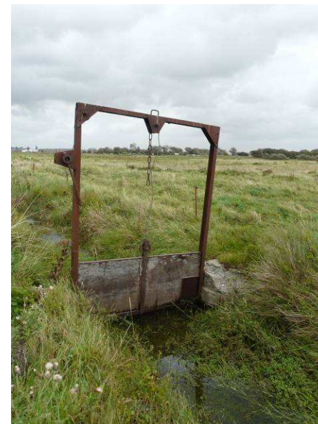
Figure 10 : écluse amont sur le fossé de l'Hôpital
