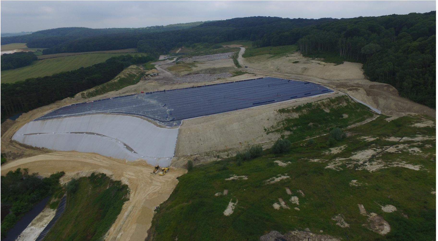
Travaux de réaménagement définitif en cours sur VVIE 4 : pose de la membrane
