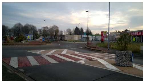
Trottoirs et passages protégés Rue Constant Darras (RN43)
