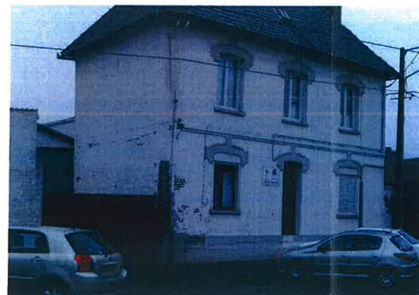
5 Maison et hangar
