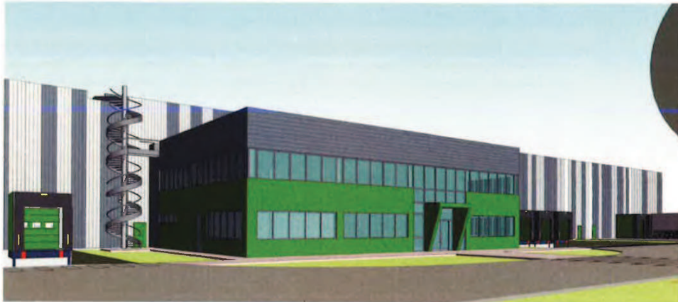
PC6-2 Vue entrée des bureaux
