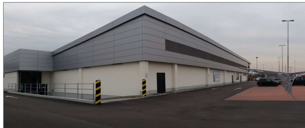
Bardage métallique alucobond recyclable à 100%
