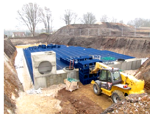
Construction d'un bassin de rétention enterré
