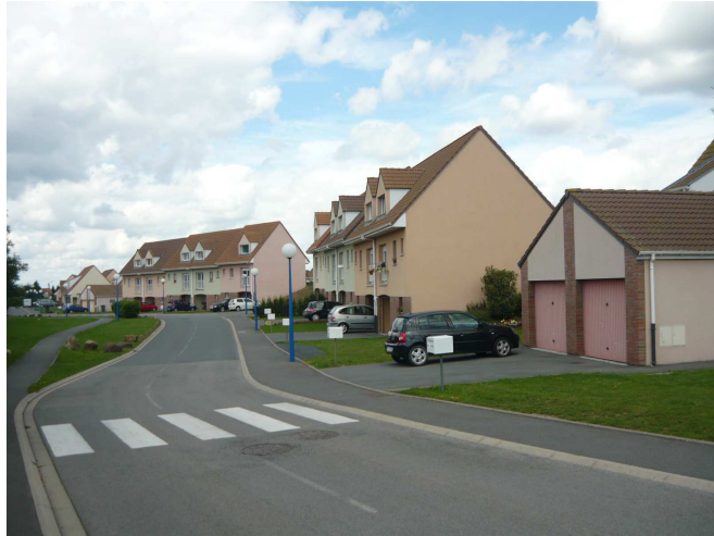
Habitat individuel rue de la Pierre au Puits
