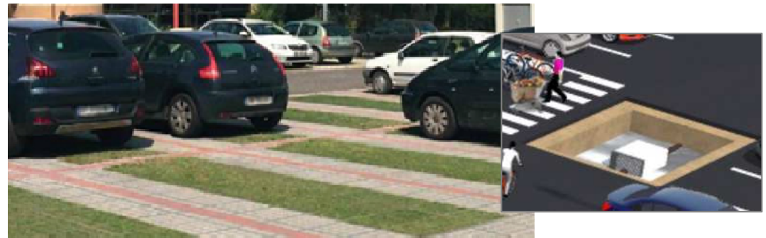
Photos de places perméables et schéma de récupérateur à hydrocarbures
