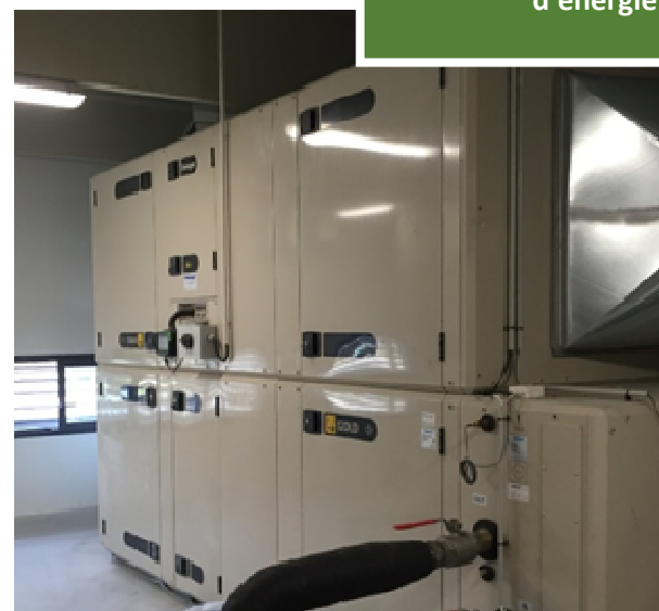
Schéma et photo d'une Centrale à Traitement d'Air double flux
