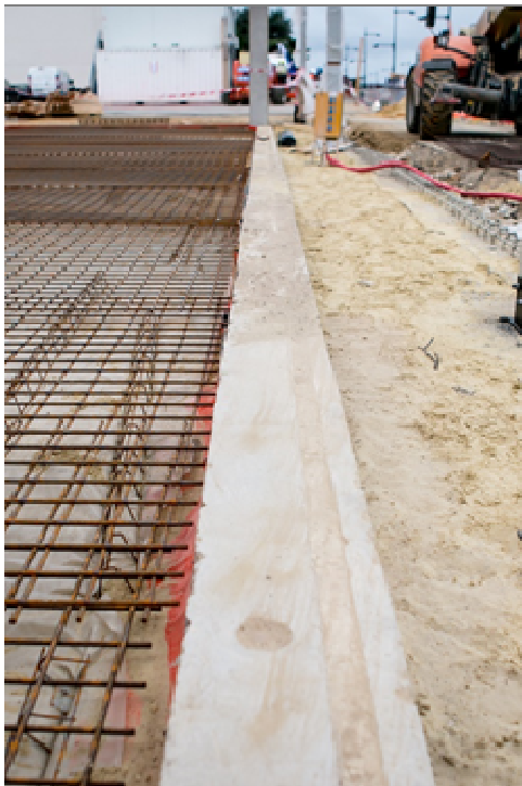
Un isolant intégré à la longrine de soubassement
