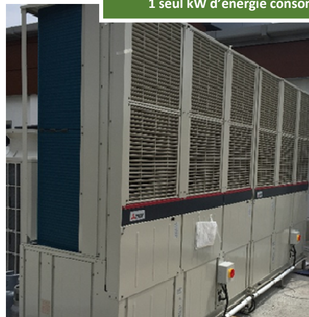
Compresseurs pour la production de chauffage/climatisation
