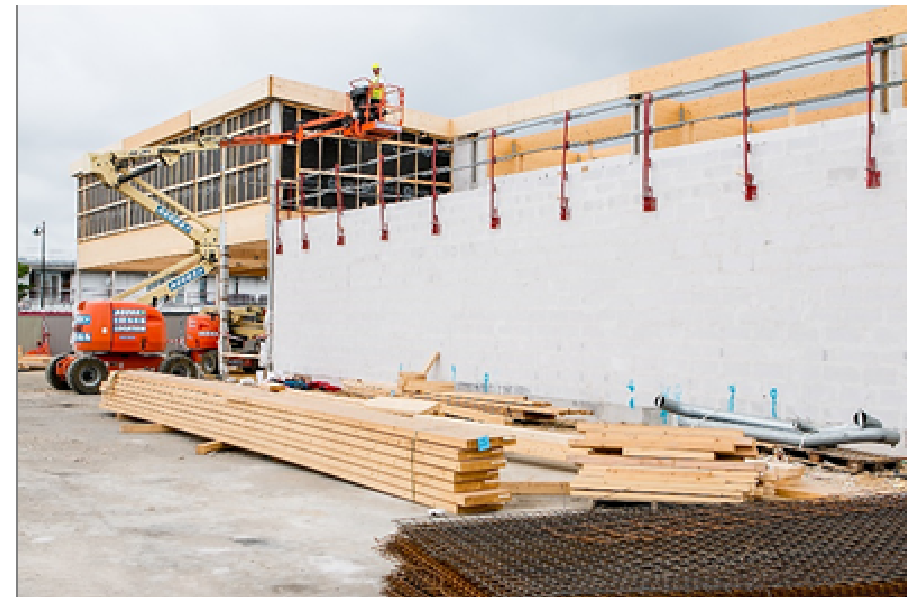
Une charpente bois avec une façade en béton cellulaire
