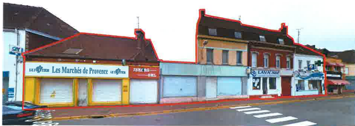
Bâtiments concernés par les travaux de déconstruction
