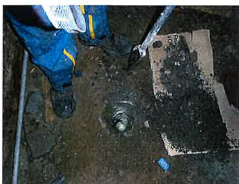
Figure 7 : Photographie du remblai rencontré lors de la foration
