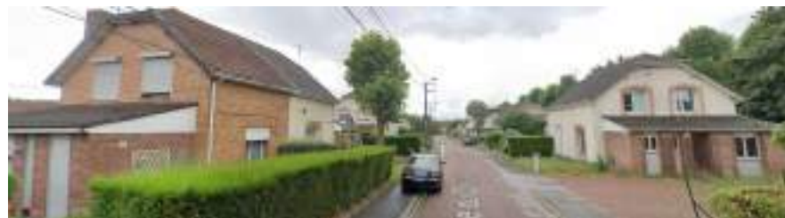
Figure 2 : Photographie de la rue du Chevalet– Source : Google Street View
