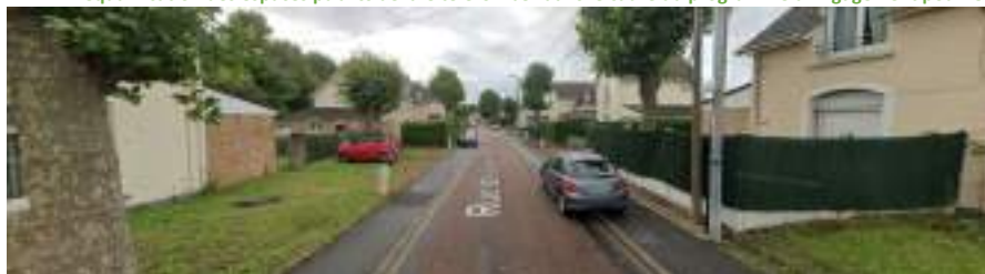
Figure 4 : Photographie de la rue des Boiseurs– Source : Google Street View
