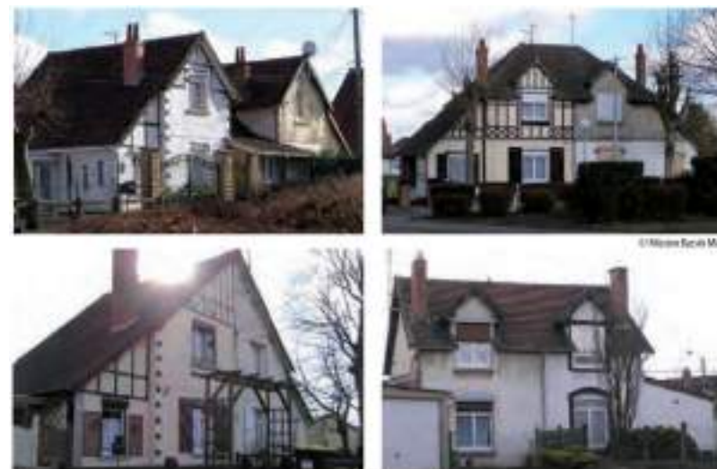
Figure 105 : Richesse des façades et des volumétries de la cité Crombez- Source : © Mission bassin minier
