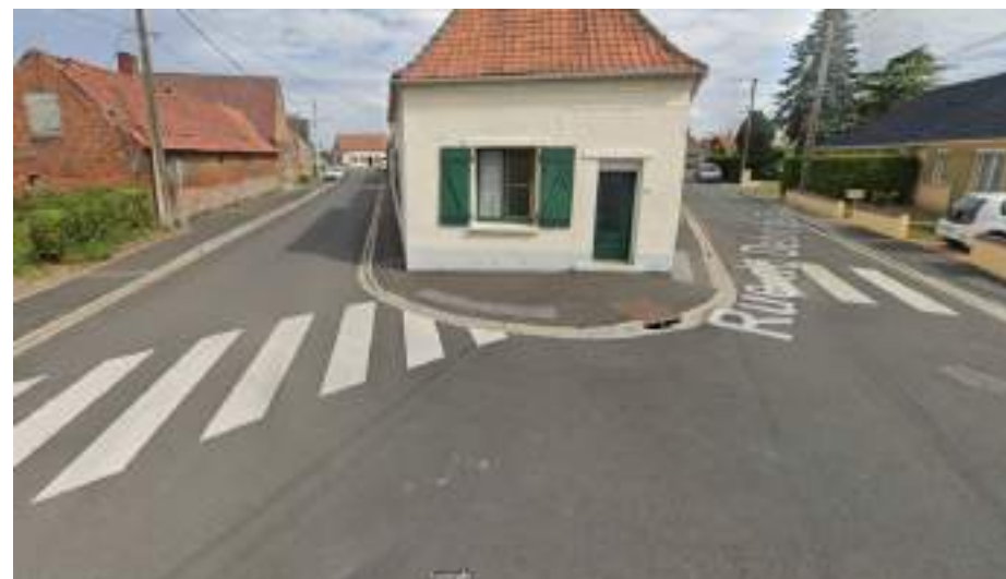
Figure 84 : Prise de vue des trottoirs et passages piétons de la rue Saint-Pierre et de la rue du Débit de Tabac – Source : Googlestreetview2022
