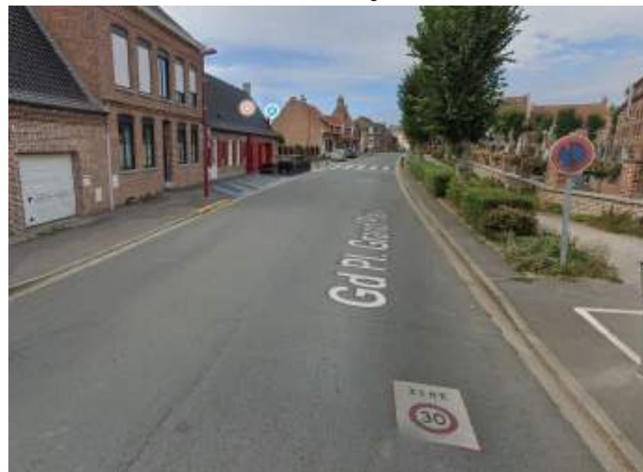
Figure 85 : Prise de vue des trottoirs et passages piétons de la rue Grand Place – Source : Googlestreetview2022
