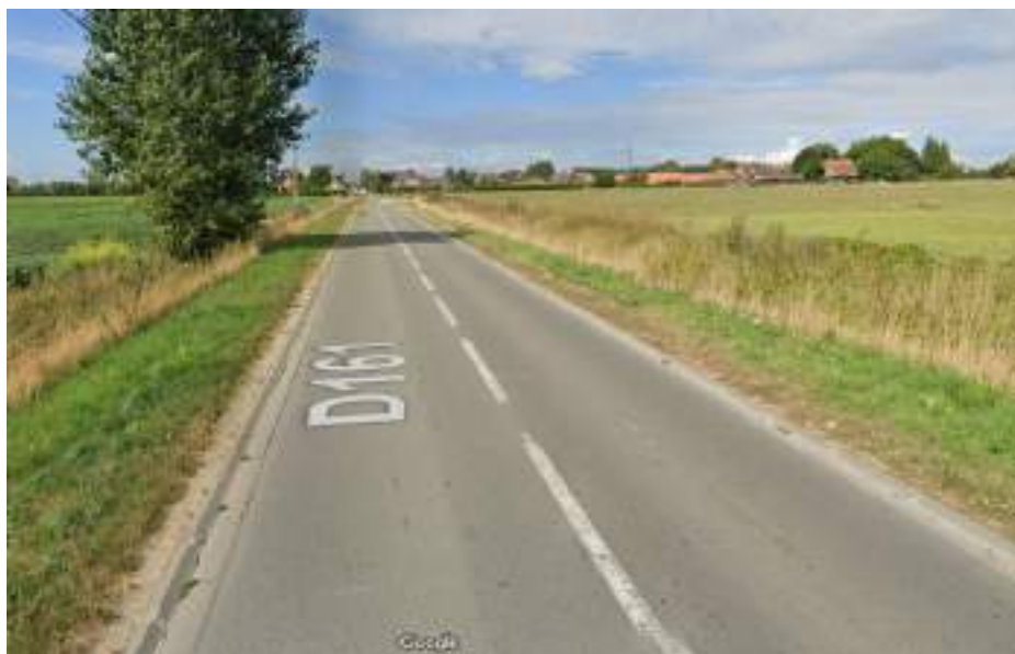
Figure 86 : Prise de vue des accotements de la D161 en limite du site d'étude – Source : Googlestreetview2022
