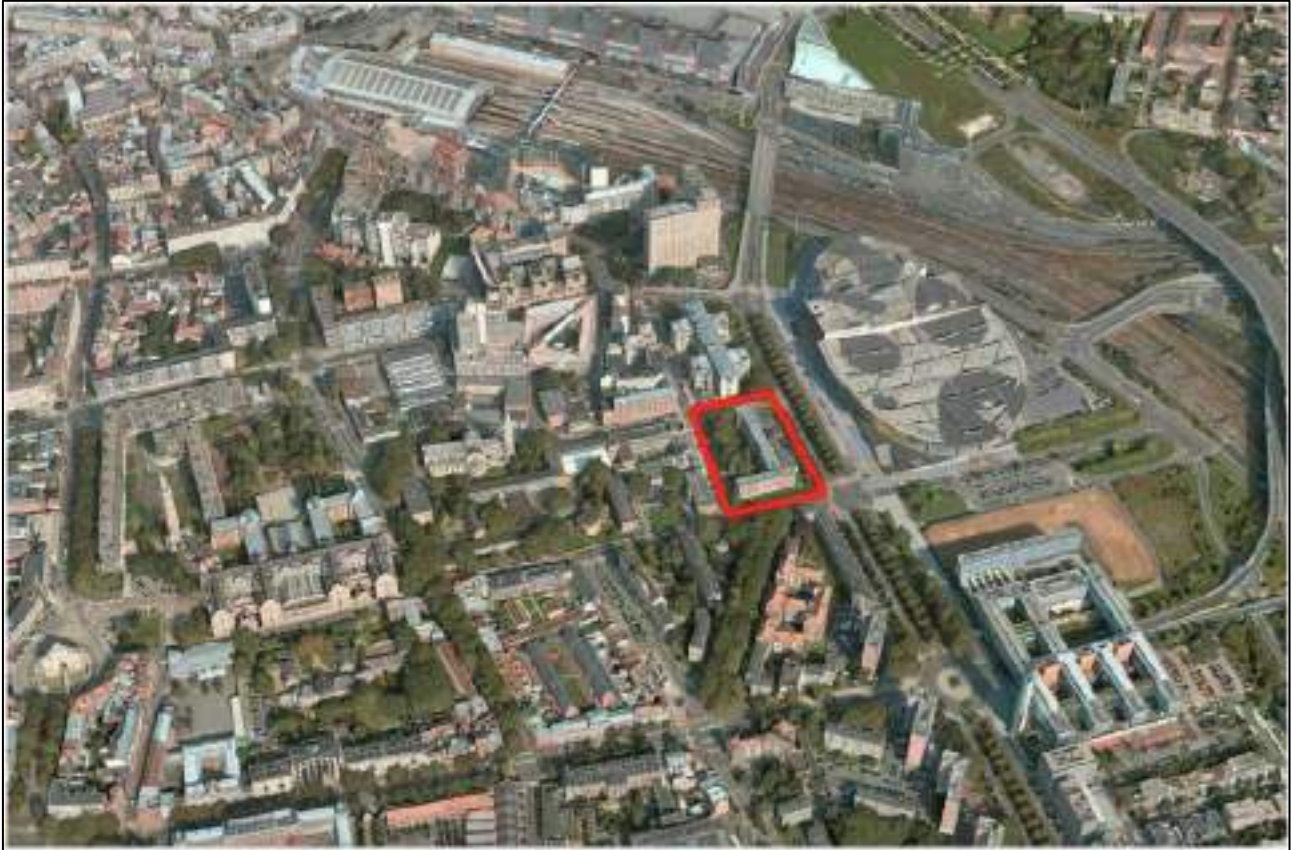
Illustration 4 : Situation de l'ensemble de logements existants, objets du projet de réhabilitation – Source Nové
