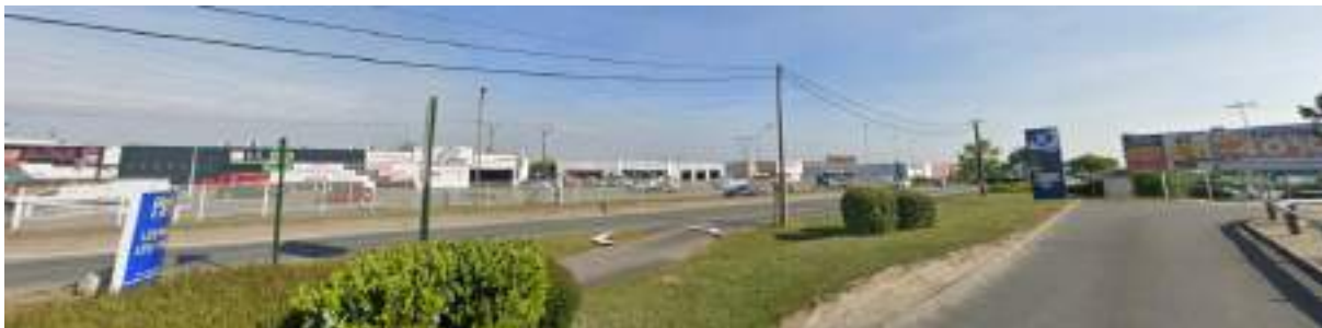
Vue depuis le terrain, en direction de la route de Lille, présentant les batiments commerciaux de la zone.
