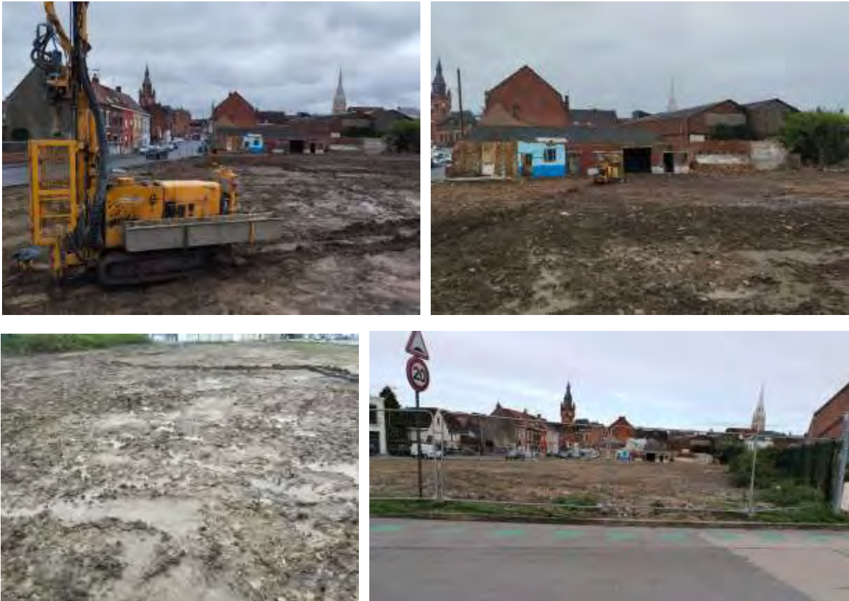
Photographies du site prises lors de notre intervention
