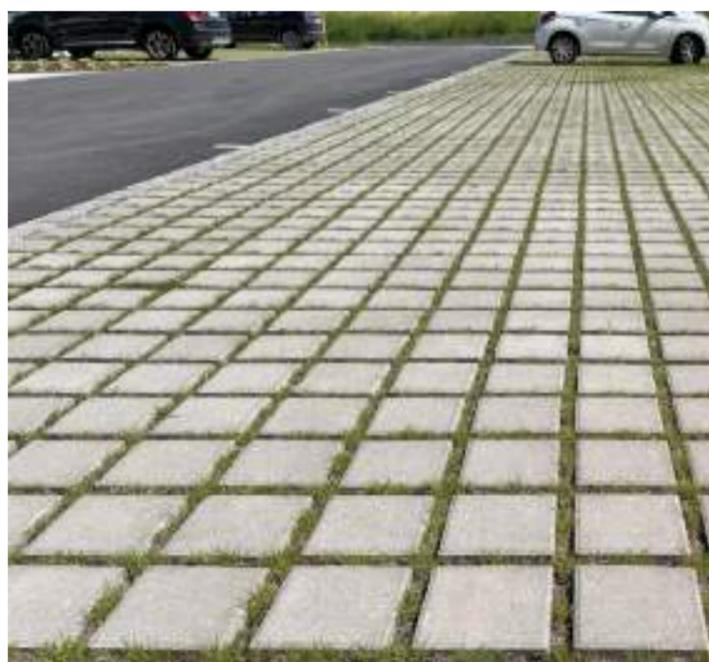
Stationnement en pavés joints gazon (20x20, joints 15 mm, ép. 10 cm)
