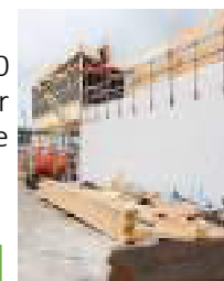
Isolation permettant de supprimer les ponts thermiques.
