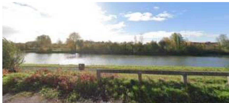
Figure 78 : Prise de vue du Canal d'Aire – Source : street view 2020
