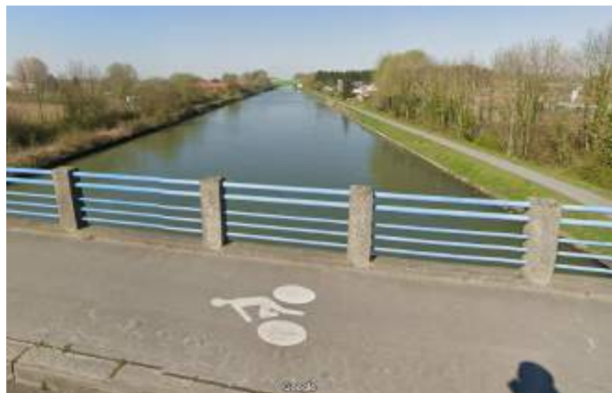
Figure 79 : Prise de vue du canal d'Aire – Source : Street view 2021
