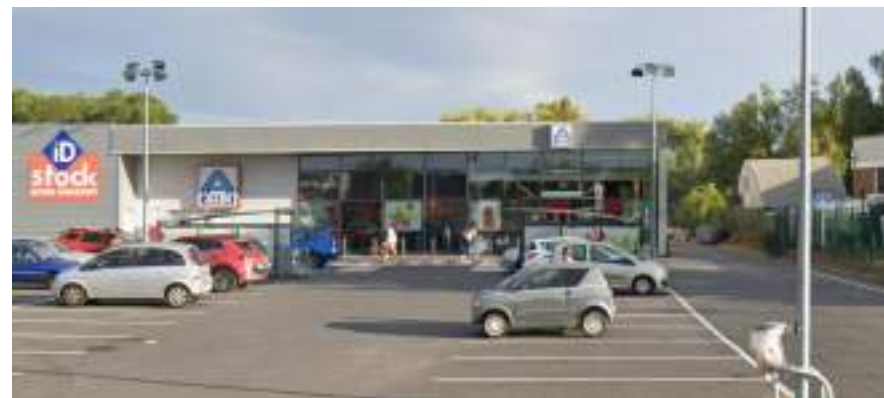
Figure 10 : Magasin ALDI existant – Source : googlemaps street view septembre 2022
