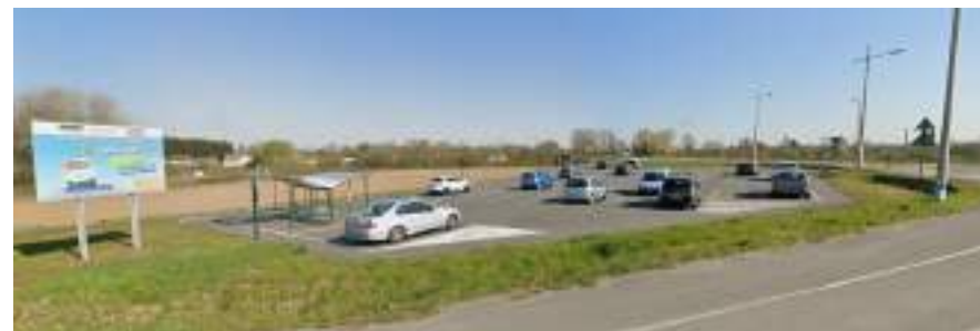
Figure 64 : Aire de covoiturage – Source : streetview 2021
