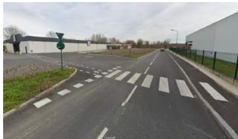
Figure 85 : Trottoirs et passages piétons dans l'environnement immédiat du projet – Source : Googlestreetview mars 2022 et mars 2023
