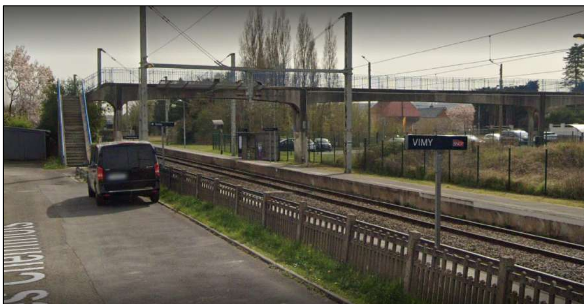
Photo 3. Gare ferroviaire de Vimy
