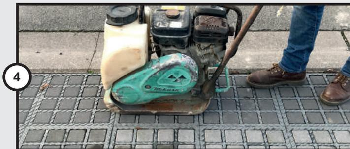
**1. REMPLISSAGE** en pavés béton
