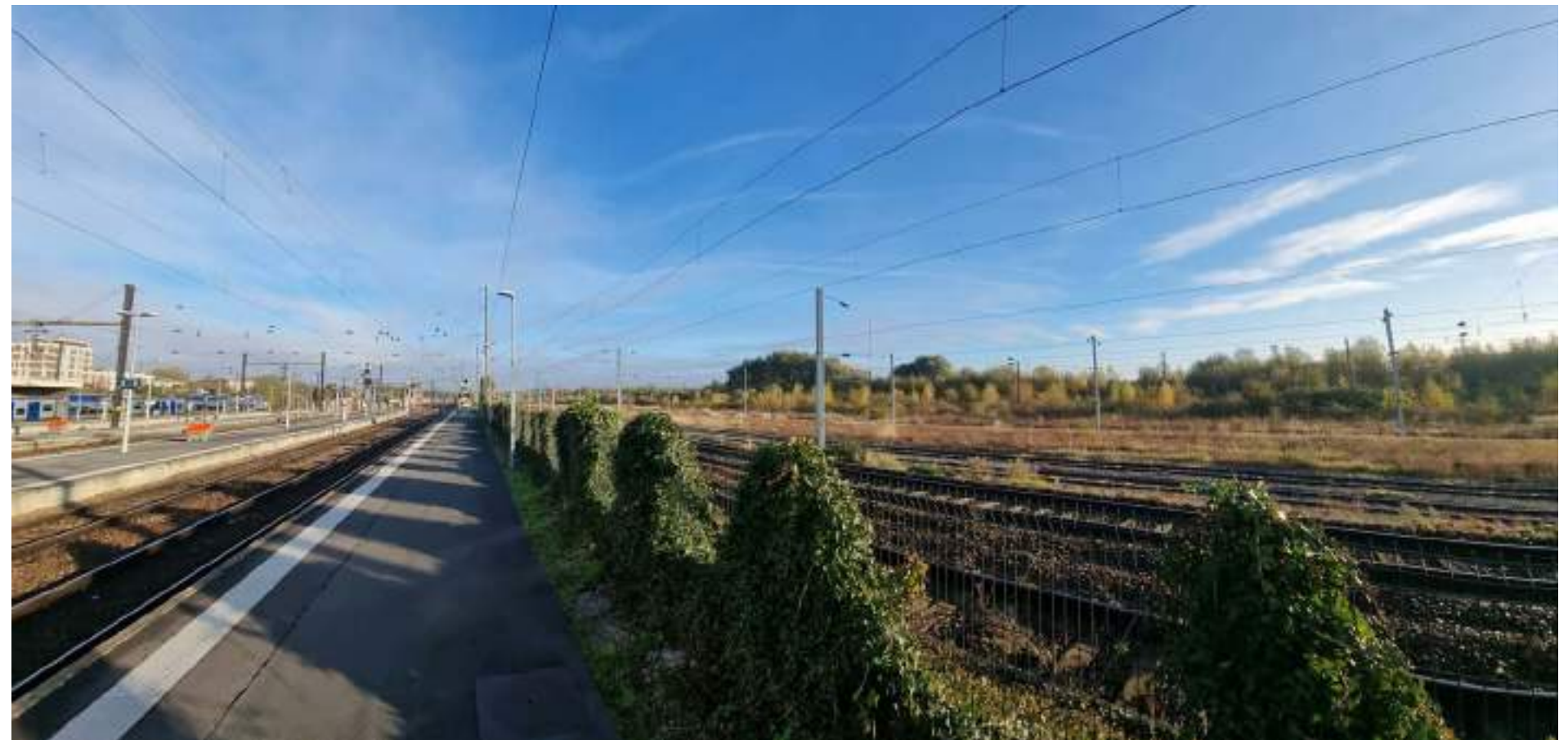
03 Vue depuis la gare SNCF en direction du site
