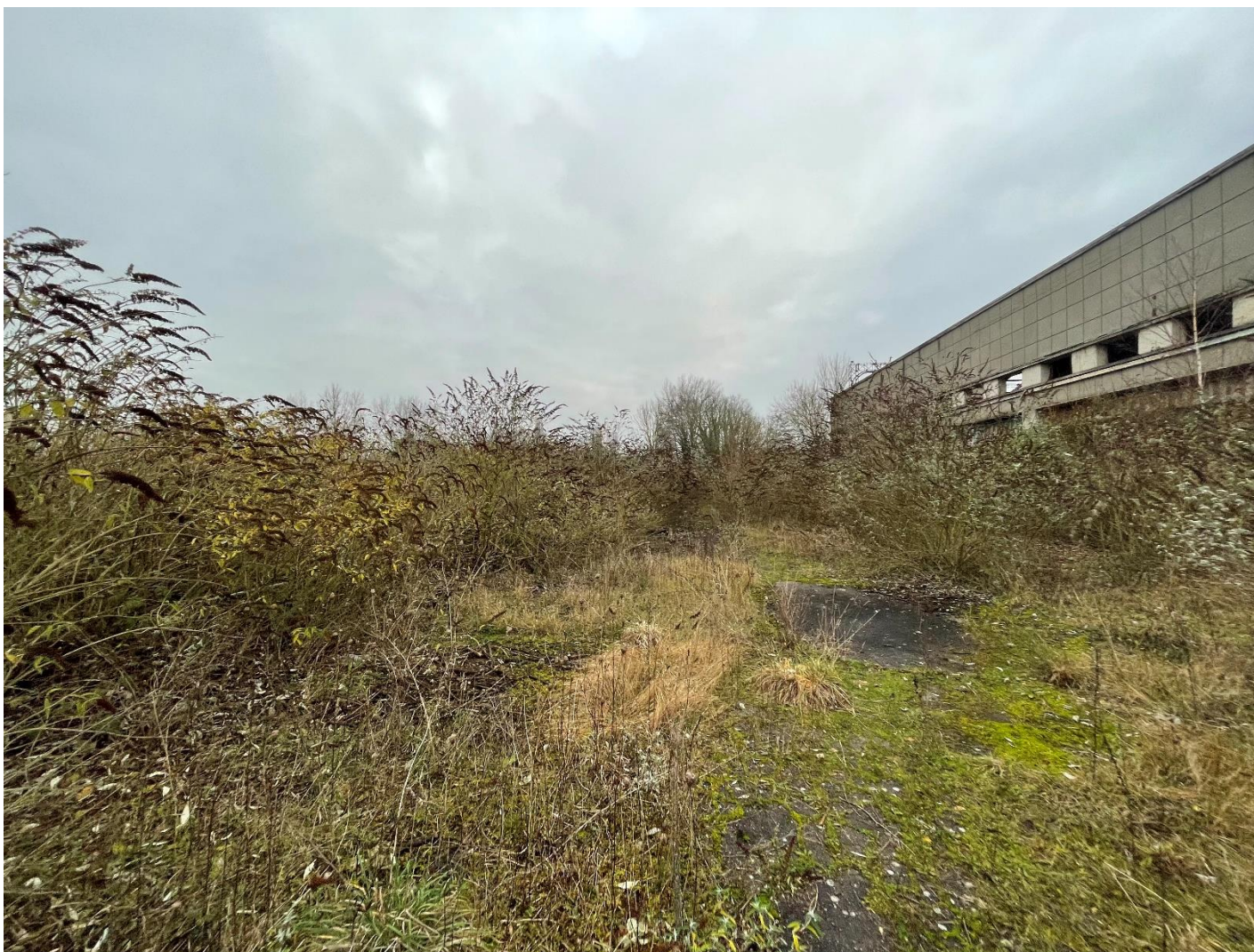
Photographie 5 : Vue de la partie Ouest du site d'étude depuis le Sud-Ouest
