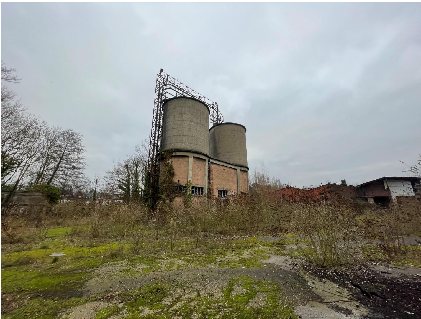
Photographie 9 : Vue de la partie Nord du site d'étude depuis l'Ouest
