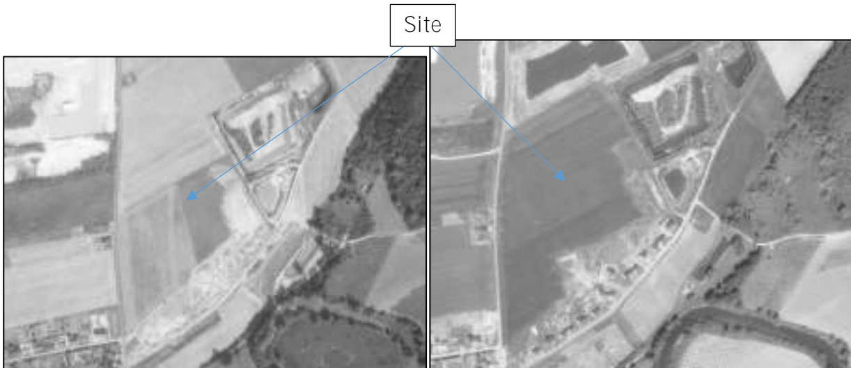
Photographies aériennes de 1979 (gauche) et 1984 (à droite)
