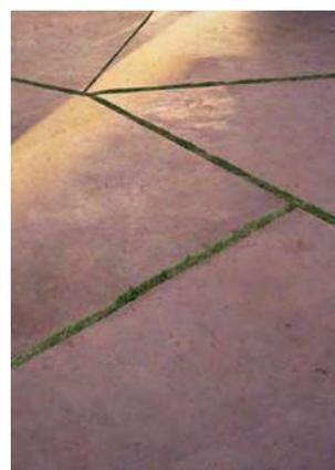
Enrobé à joints moussus (mélange de terre avec un système écovégétal moussus pour une reprise directe des mousses sans adventices) / Exemple calepinage possible
