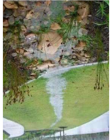
Figure 7 : Exemple de noue
