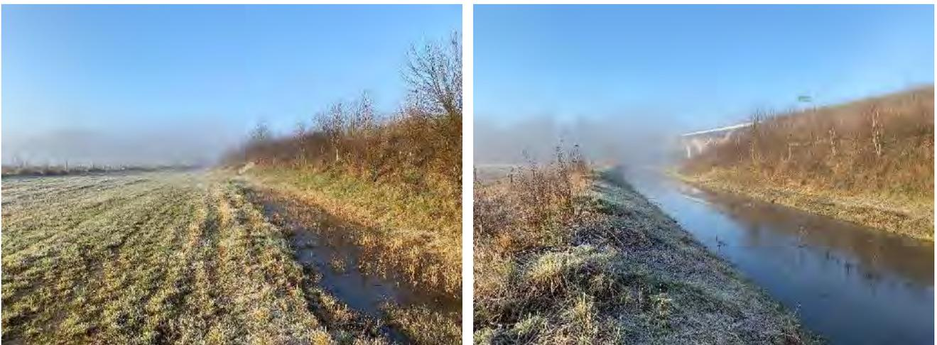
Figure 5 : stagnations d'eau le long du remblai du viaduc de la RD915 le 05/01/2020
