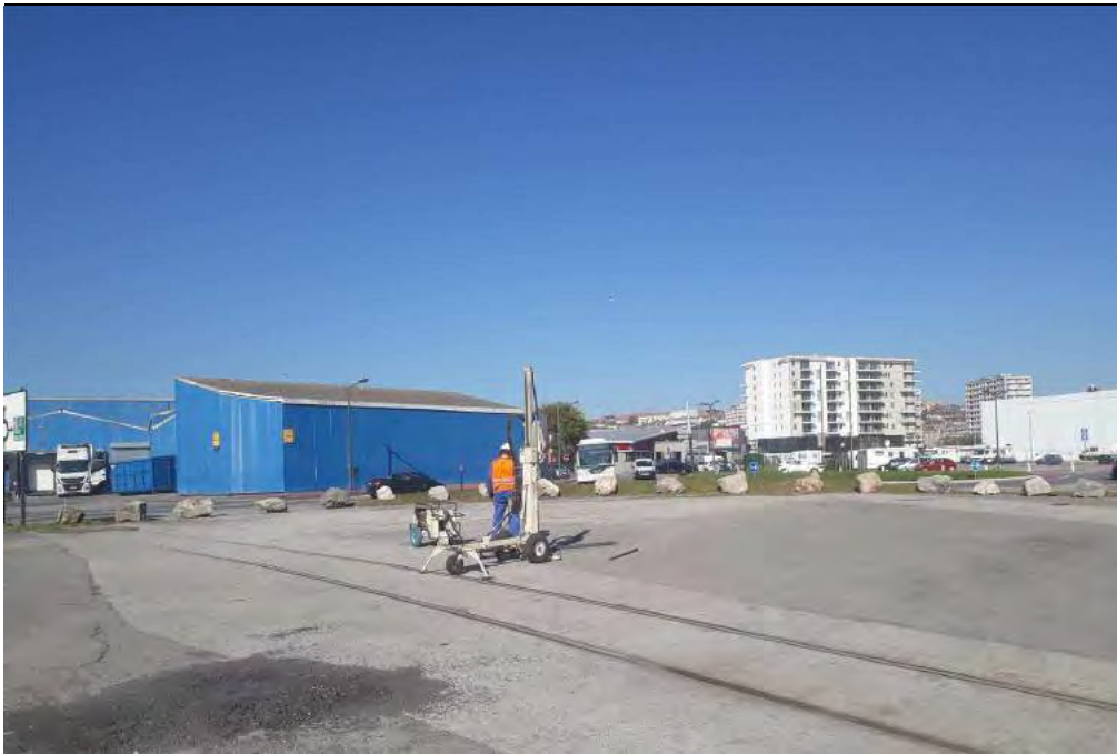
Figure 1.1 Sondage TW1, Nord-ouest du site, zone en enrobé au Nord des rails
