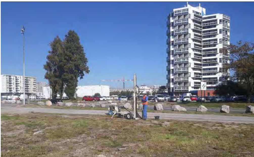
Figure 1.2 Sondage TW2, Nord-est du site, zone enherbée au Sud des rails
