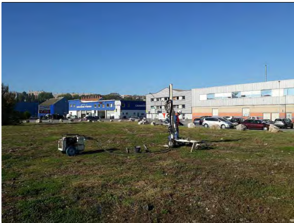
Figure 1.7 Sondage TW7, Sud-ouest du site
