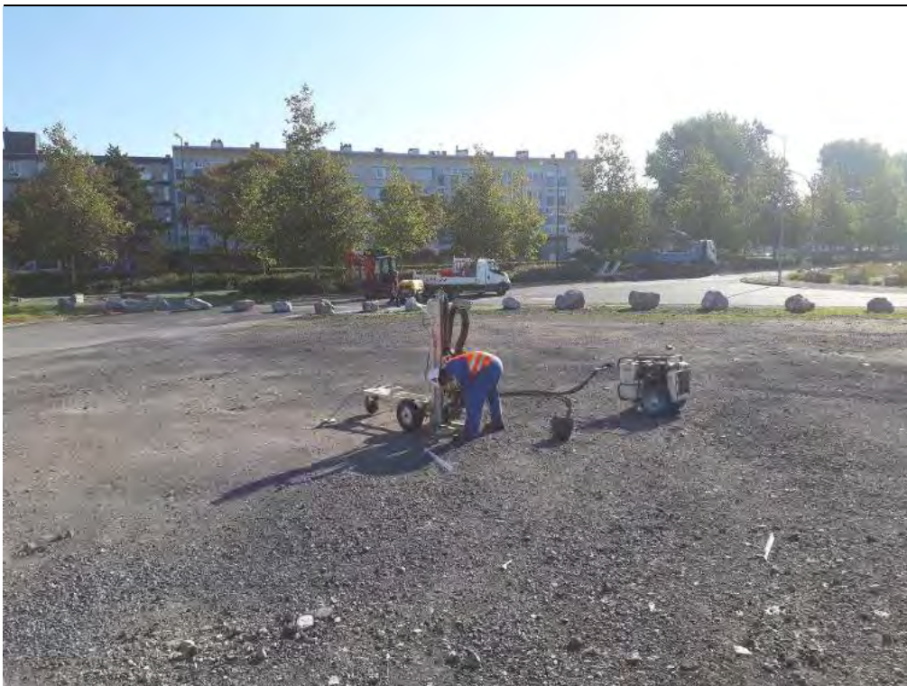
Figure 1.6 Sondage TW6, Sud-ouest du site
