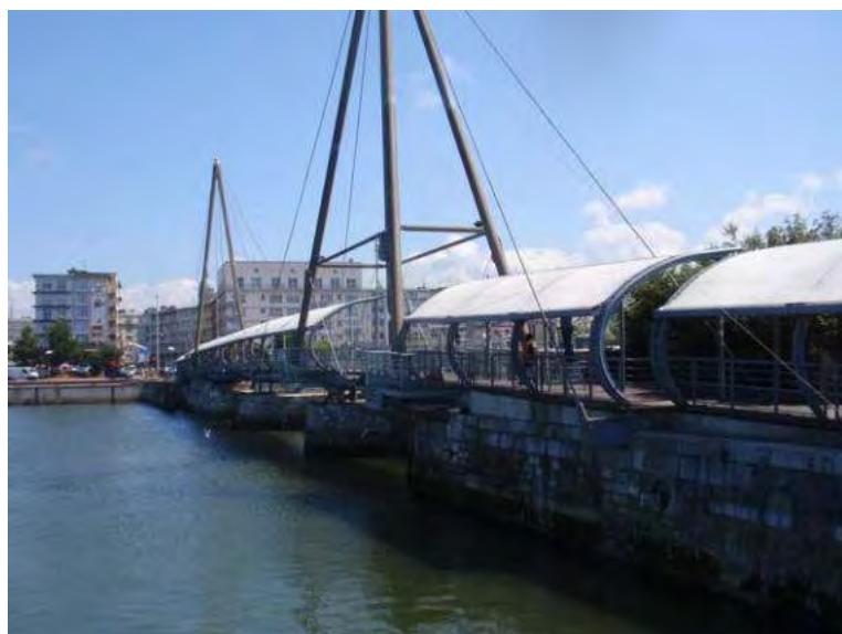
Passerelle piétonne le long du pont Marguet
