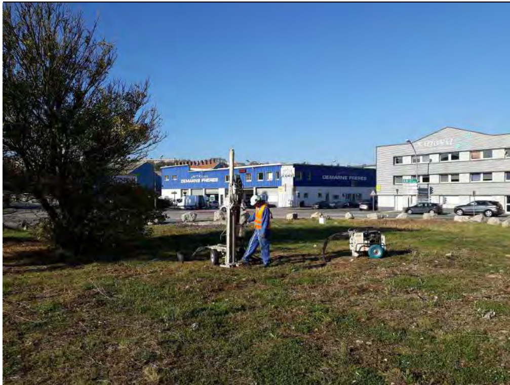
Figure 1.9 Sondage TW9, Sud-ouest du site, au Nord de la rue d'Alsace
