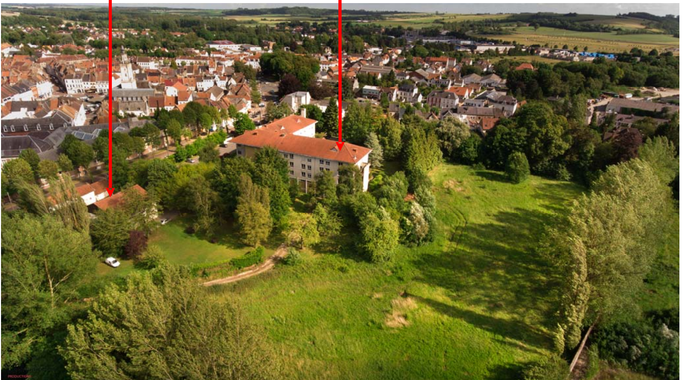
Vue aérienne sur le site du Centre Hospitalier d'Hesdin
