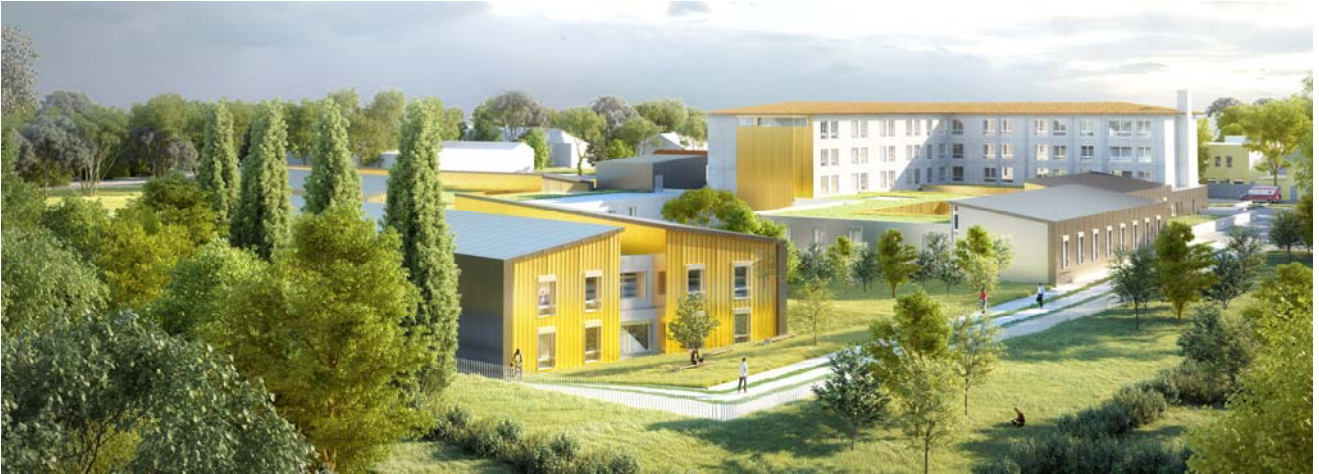
Vue sur l'extension et le bâtiment Richelieu existant – au Sud du site
