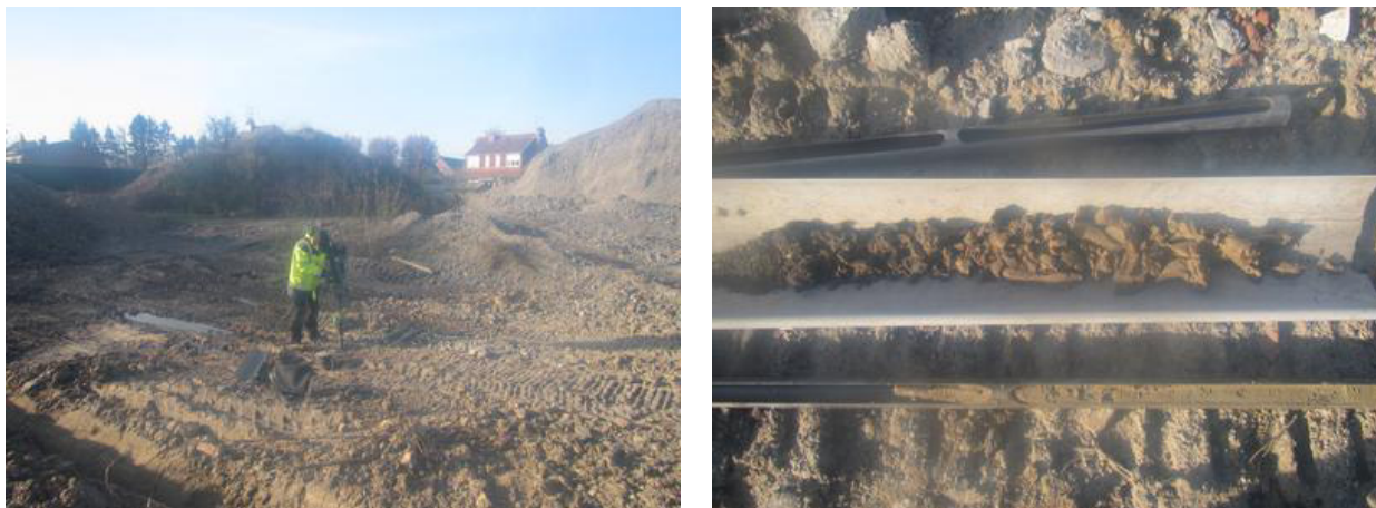
Figure 6 : Technique de forage au carottier portatif
