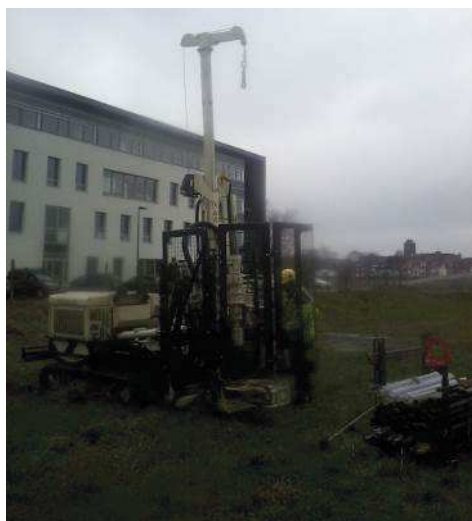
Photographie n°1 : Atelier de sondage (source : EACM, 01/03/2016)
