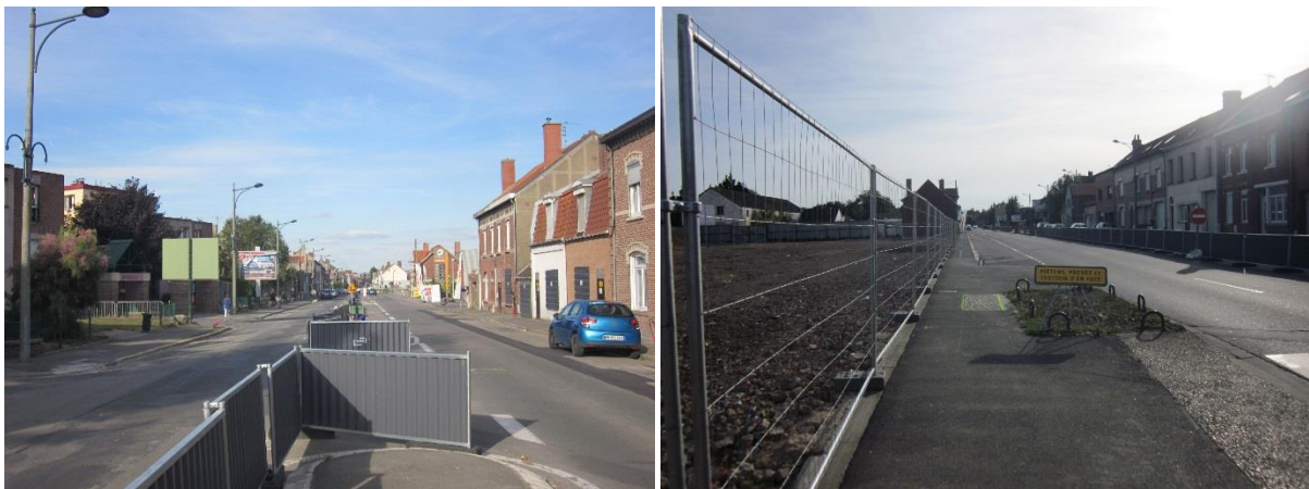
Rue du Maréchal Delattre de Tassigny entre le giratoire Blériot et le centre Nauticaa (vers le centre Nauticaa à gauche et vers le giratoire à droite)
