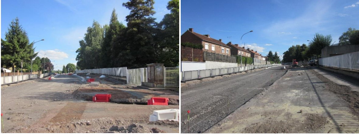
Travaux en cours le long du lycée Henry Darras (à gauche) et entre la rue Nobel et le Chemin de Manufactures (à droite)
