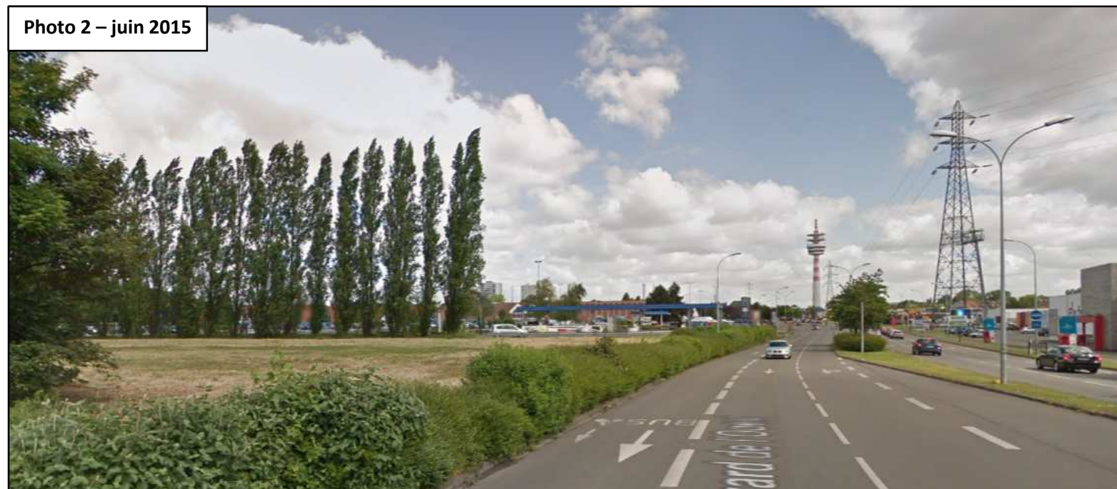
Annexe 3 – Photographies de la zone d'implantation
