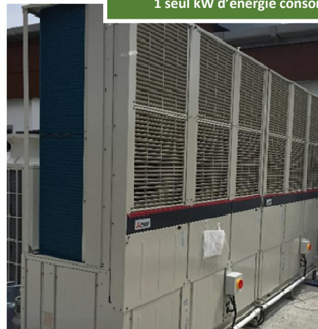
Compresseurs pour la production de chauffage/climatisation
