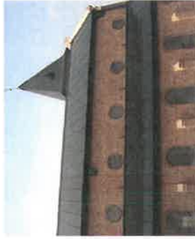
Eglise avec son toit de panneaux solaires
