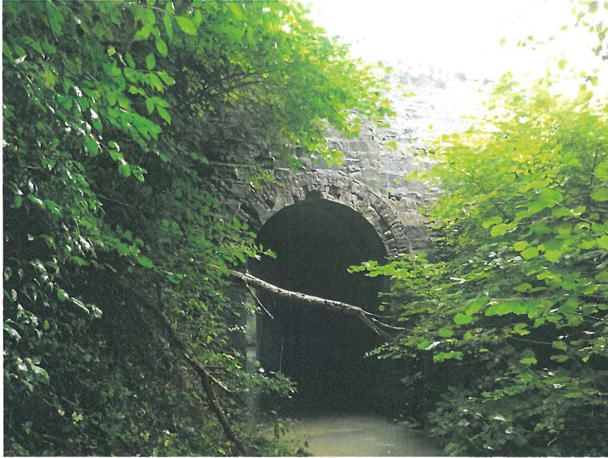
Aperçu tête de pont amont
