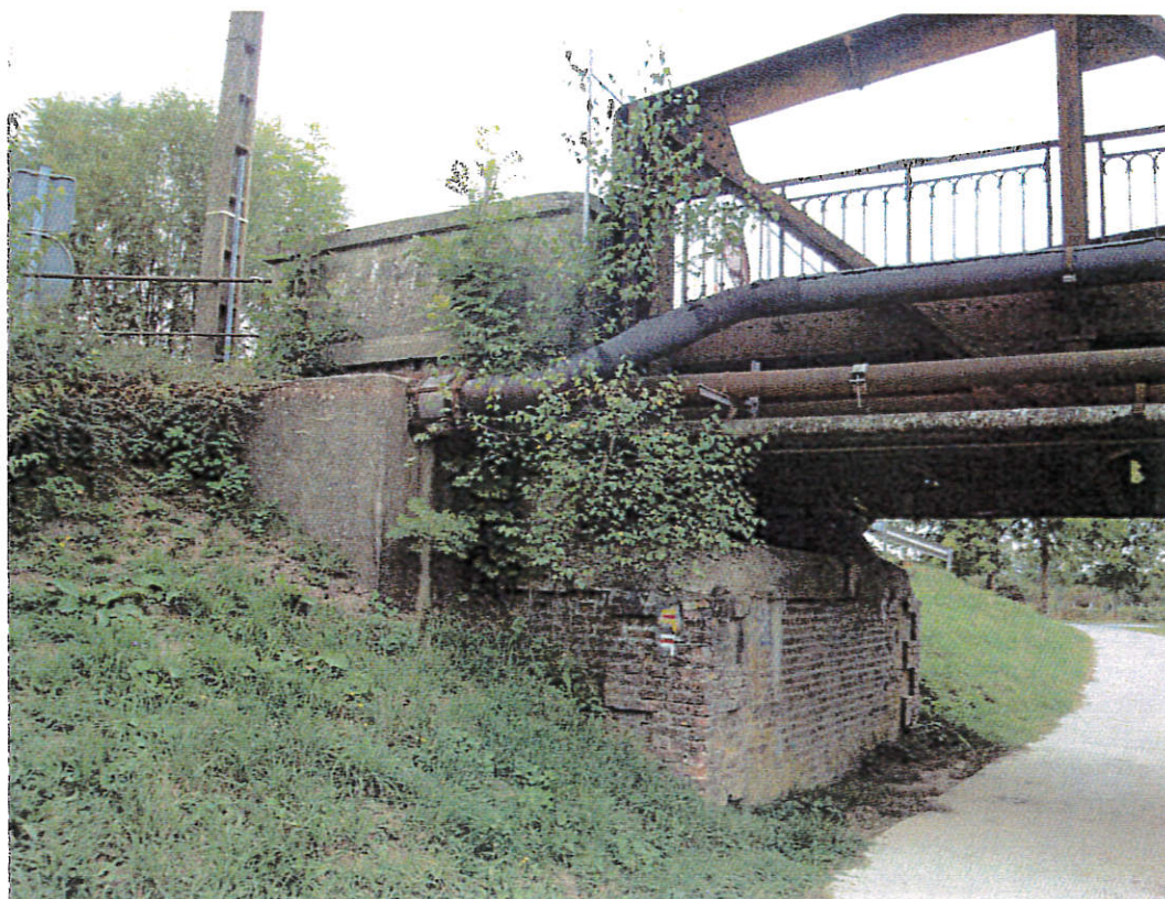
6. Vue de la culée existante conservée rive gauche
