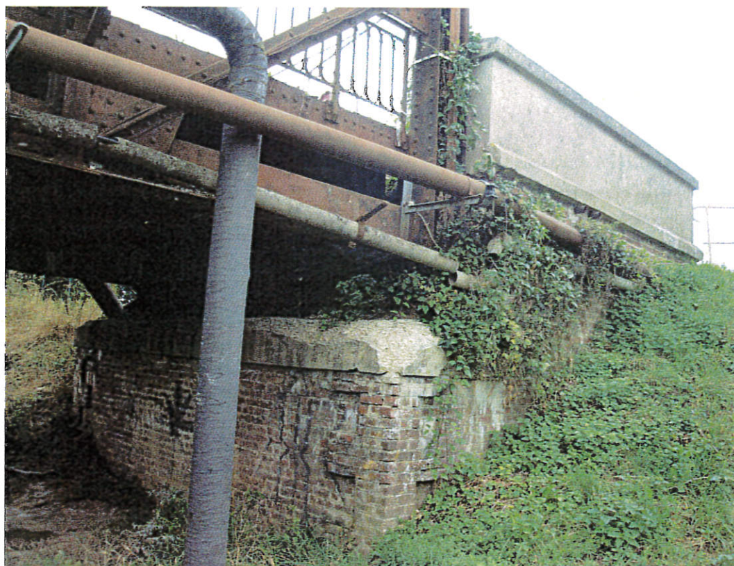
6. Vue de la culée existante conservée rive gauche
