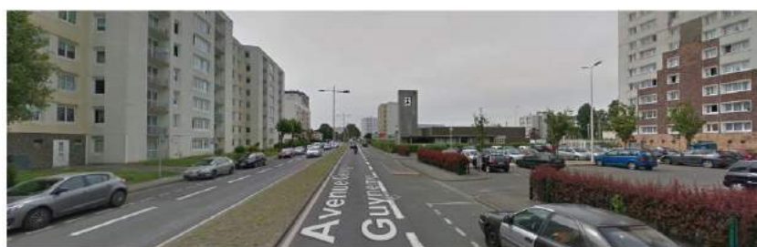
VUE ETAT EXISTANT
