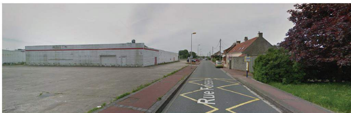
VUE ETAT EXISTANT
