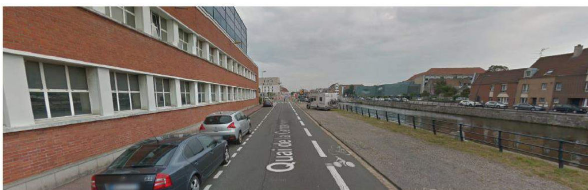
VUE ETAT EXISTANT
