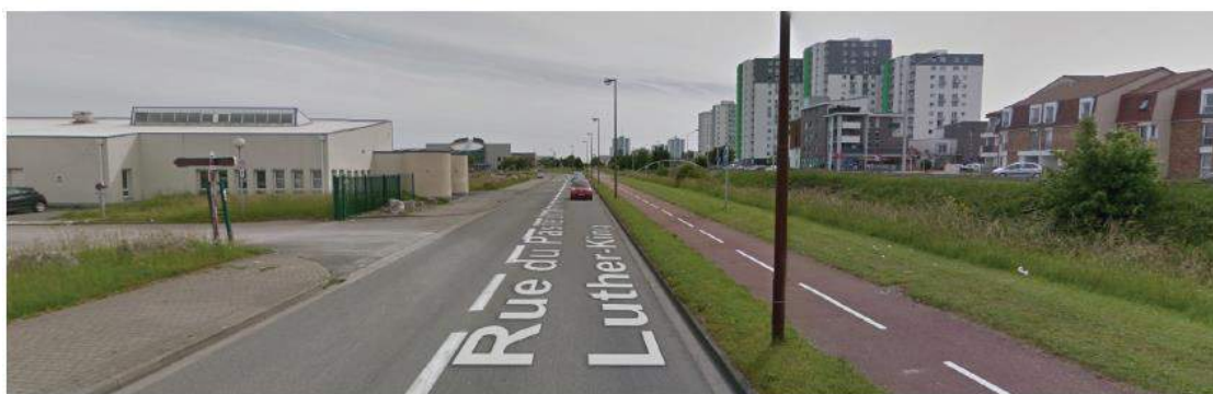
VUE ETAT EXISTANT (Rue M. Luther King)
