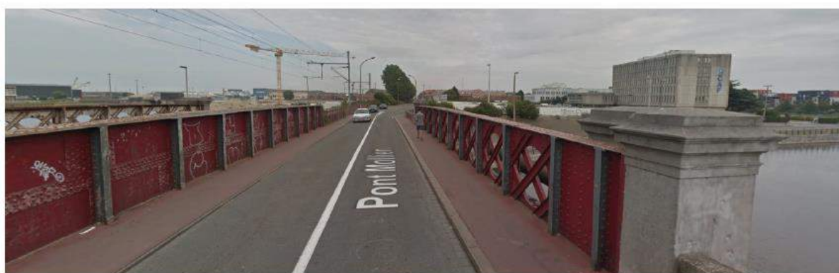
VUE ETAT EXISTANT
