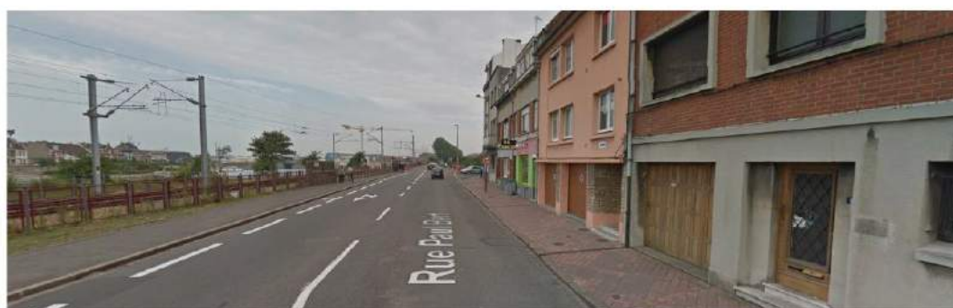
VUE ETAT EXISTANT
