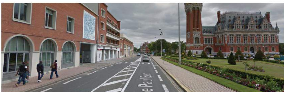
VUE ETAT EXISTANT
