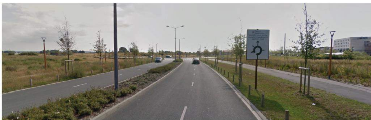
VUE ETAT EXISTANT
