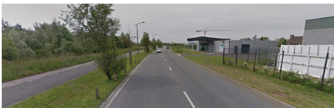
VUE ETAT EXISTANT
