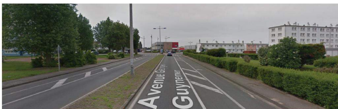
VUE ETAT EXISTANT
