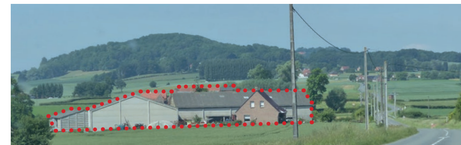
Bâtiments agricoles sans accompagnement végétal
