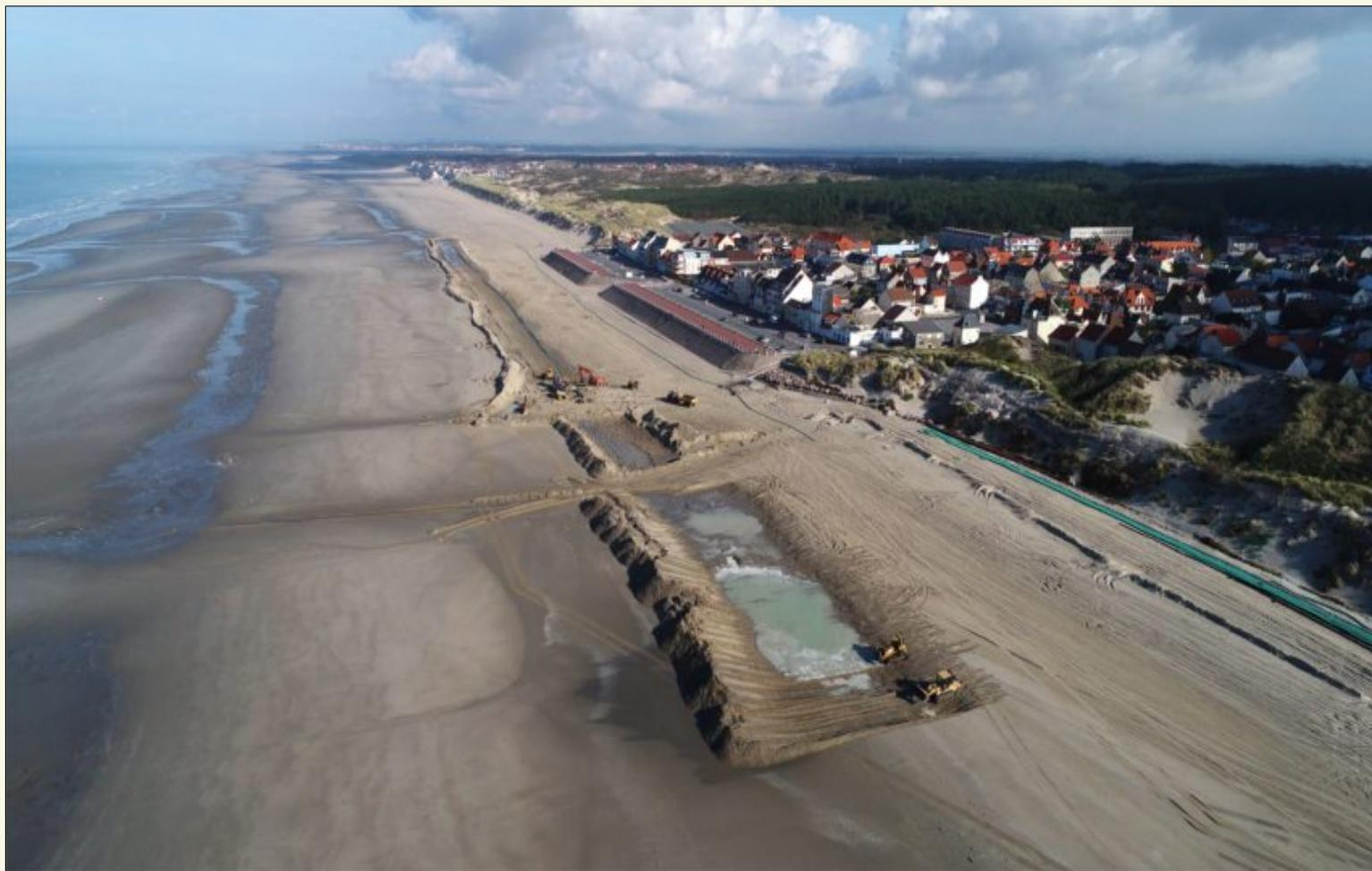
Travaux de drainage de plages : dispositif Ecoplage à Quend (80)- 2018
