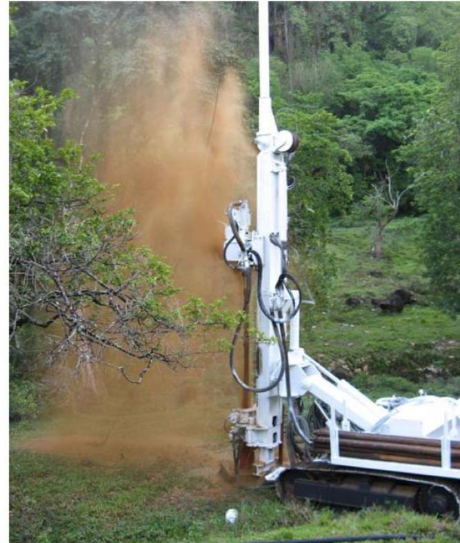
*Air-lift : Nettoyage d'un forage*
