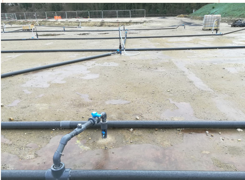
Partie du réseau de venting Crédit photo : DREAL Hauts-de-France
